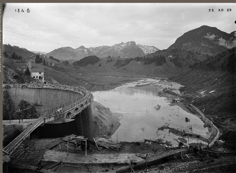
Barrage de Montsalvens, construction, formation du lac (montée des eaux), EEF, entre 1920-1921
